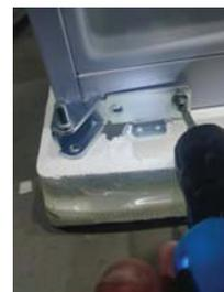
Schritt 5: Entfernen Sie das untere Scharnier
